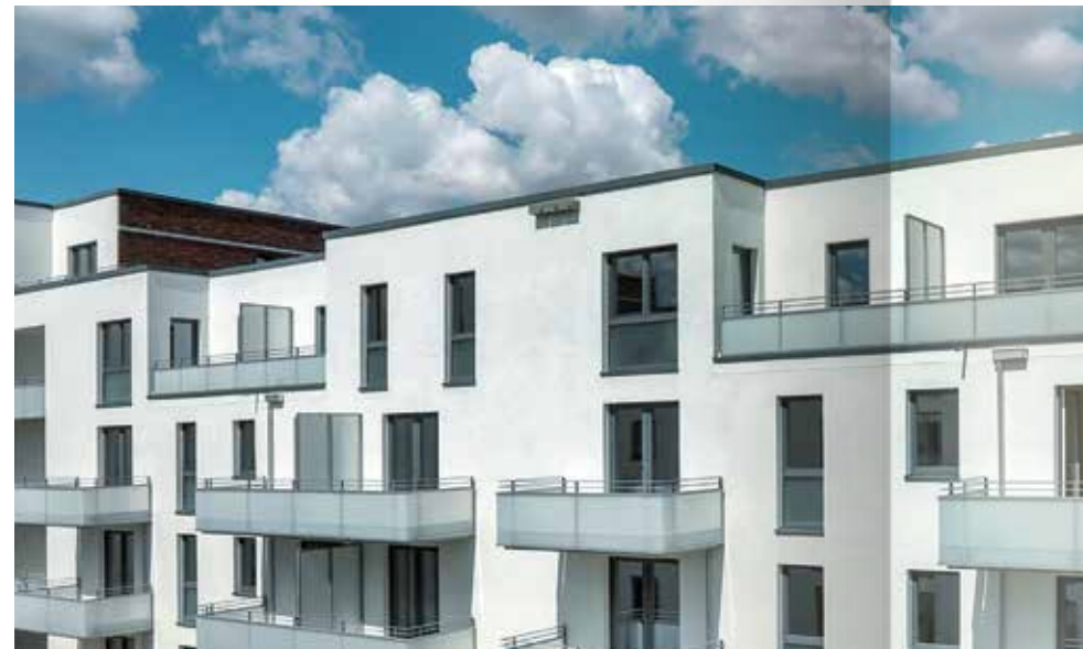
Ansichten der Washingtonhöfe: die Außenansichten mit klassischem Hamburger Rotklinker, die Fassaden zum Hof mit einem hellen Wärmedämmverbundsystem
