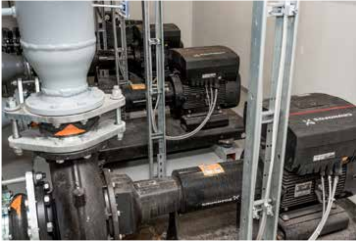
Kühlwasser-Rückläufe mit Blockpumpen vom Typ „NKE 125-200“ mit integriertem Frequenzumrichter
