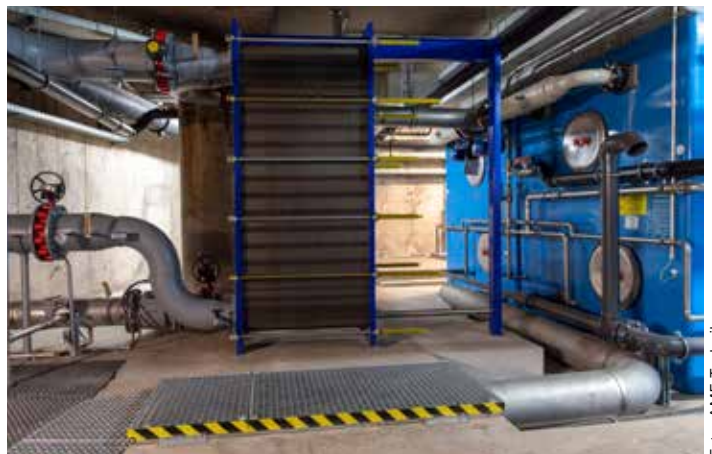
Getrennte Kühl- und offene Spühwasserkreise gegen Verkeimungen
