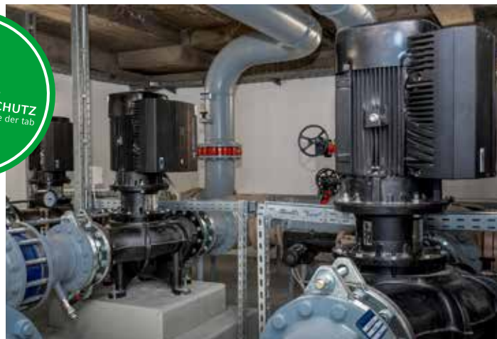
Kühlwasservorläufe mit Inline-Pumpen „TPE 200/190“ und „TPE 150-170“ mit integriertem Frequenzumrichter
