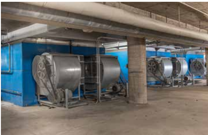
Rückkühlwerke mit Luftkühlern
