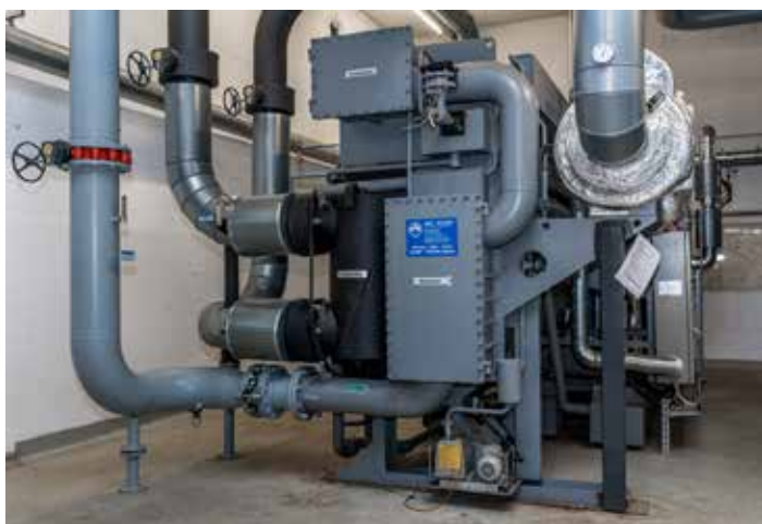
Absorber und Kaltwasser-Rücklauf 1 ...
