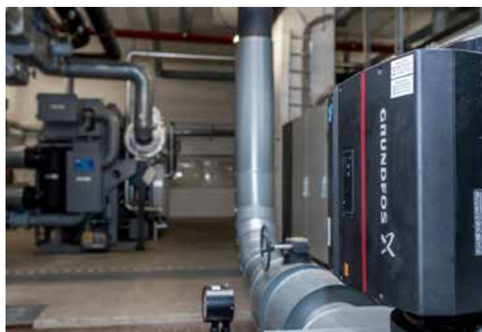
... mit Inline-Pumpe vom Typ „TPE 150-1702“
