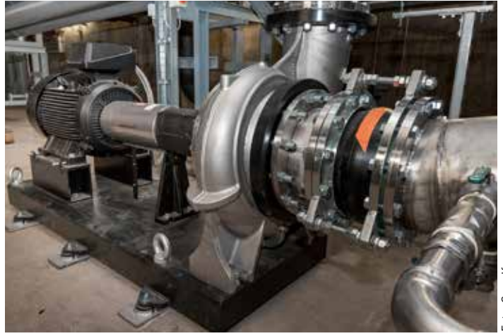
Größte Pumpe in der Anlage: anlagenspezifisch konfigurierte „NKG 300-250-400“ im Sprühwasserkreis 1 in Edelstahlausführung
