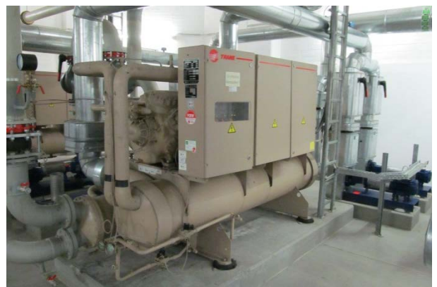
Abbildung: Prüfpflichtige Kälteanlage
