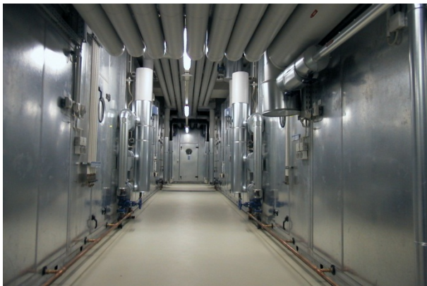
Abbildung: Prüfpflichtige RLT-Anlage
